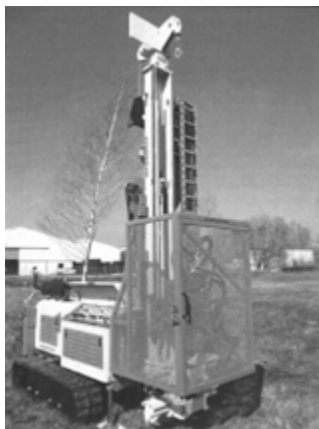
Foreuse utilisée pour les sondages géotechniques.
